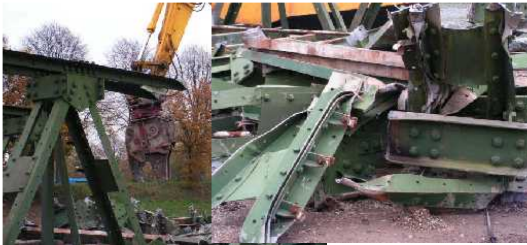
5 november 2007: Op de loswal bij de BETONCENTRALE wordt DE SCHOORBRUG met een enorme hydraulische tang in stukken geknipt. 's Avonds resteert alleen nog schroot . . . . .
